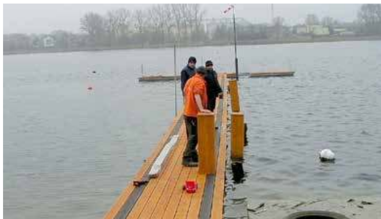
Pomost pływający na dzień przed odbiorem technicznym w poniedziałek, 21 grudnia br.
