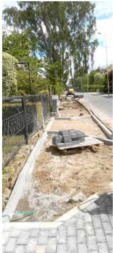
Trwa budowa chodnika wzdłuż ulicy Chopina
