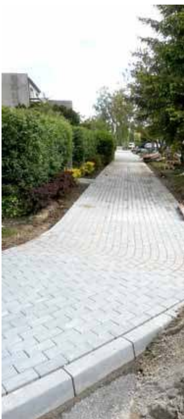
Piesi zyskają 350 metrów komfortowej nawierzchni z kostki
