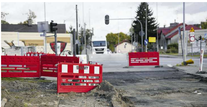
• Prace na ul. Zakładowej mają się skończyć w połowie przyszłego roku
