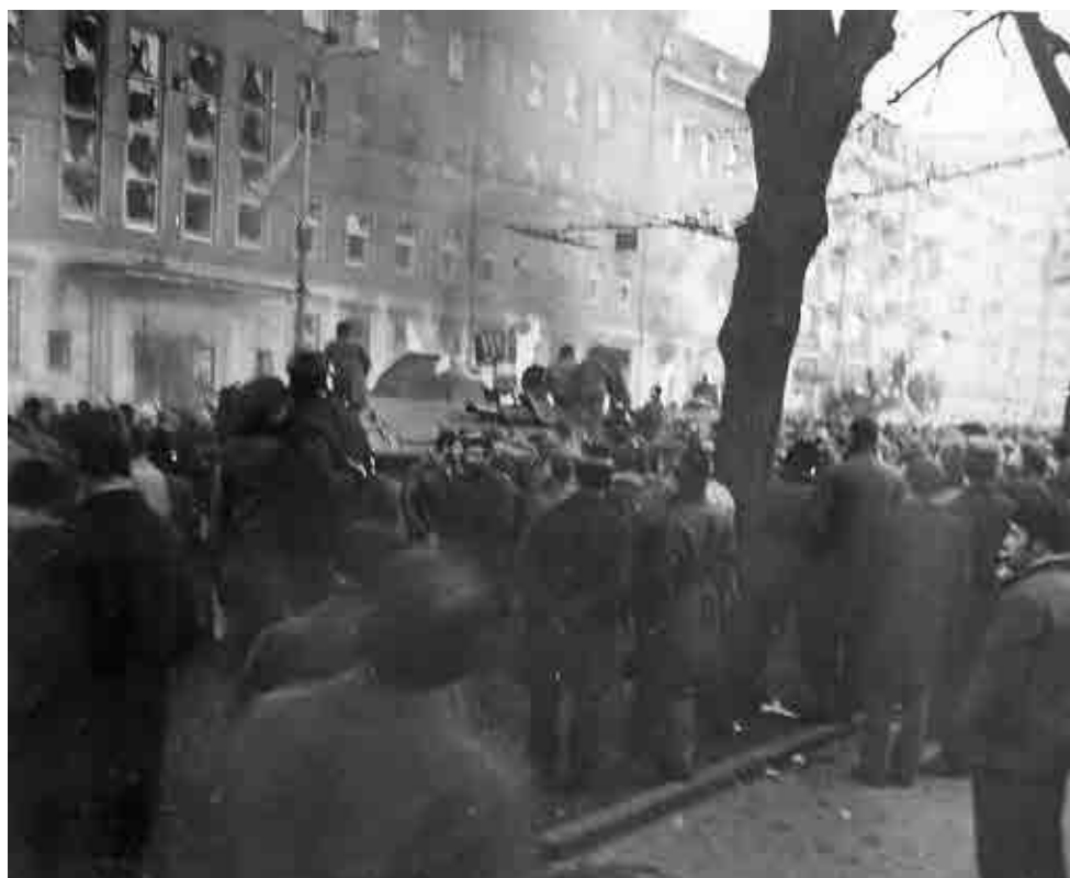
Zniszczenia w komitecie wojewódzkim w Szczecinie
