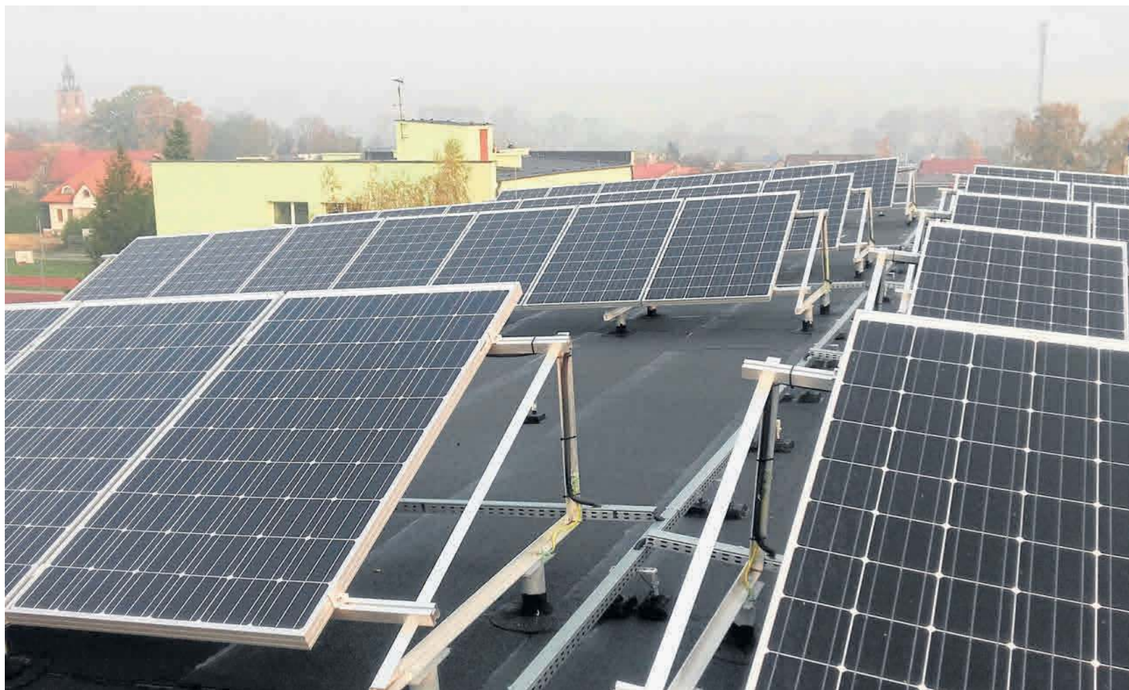
Termomodernizacja szkoły w Kłecku obejmowała także montaż paneli fotowoltaicznych. Energia przez nie wytwarzana służy do ogrzewania wody użytkowej
