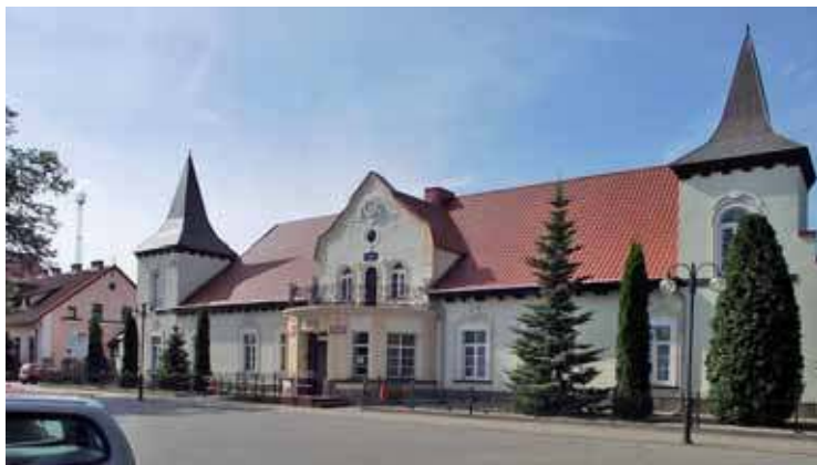
Człuchów. Budynek dawnej poczty
