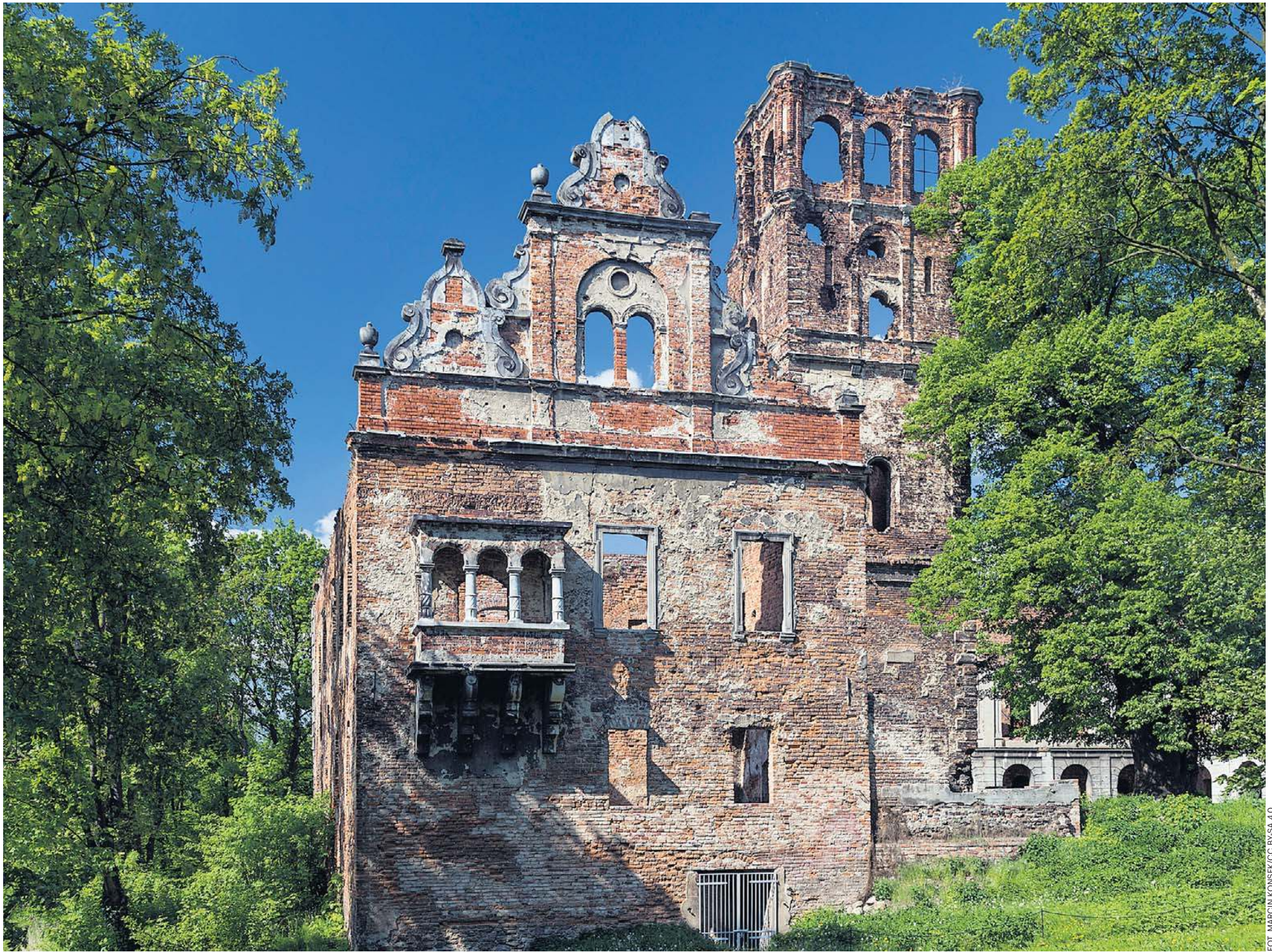
Zamek w Tworkowie powstał w XVI wieku – prawdopodobnie na fundamentach średniowiecznego zamku warownego
