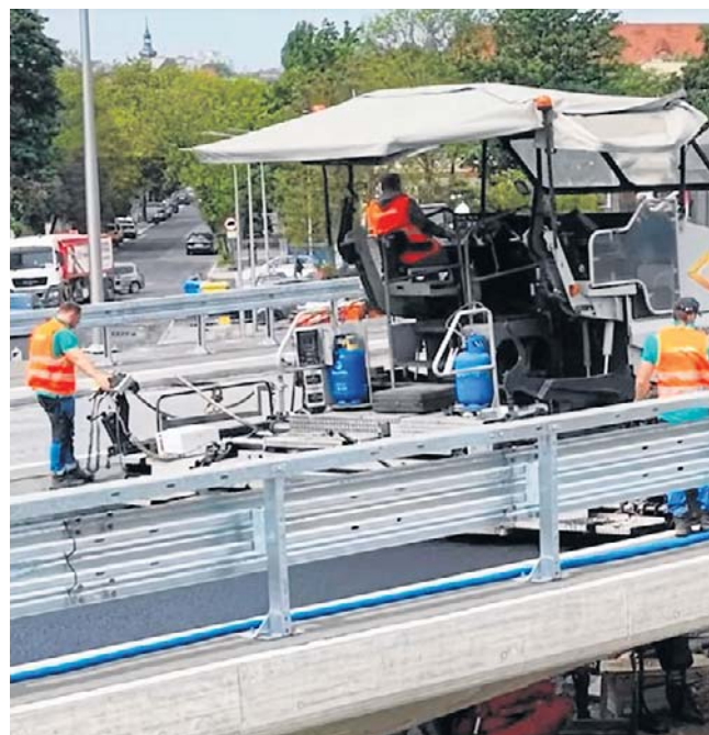
Jeszcze w kwietniu budowana w centrum miasta estakada przeszła pomyślnie próby obciążeniowe.
