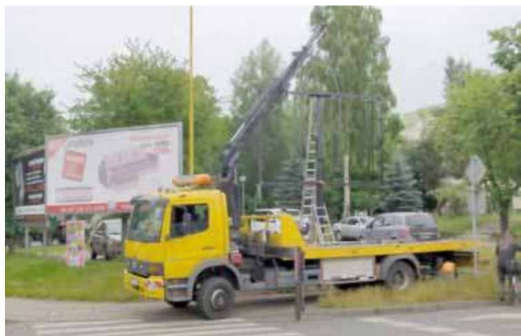
Prace montażowe telebimu odbywały się już w piątek około godziny 13
