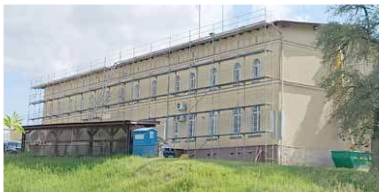
Widoczne od strony ul. Zamkowej prace w budynku ZK
