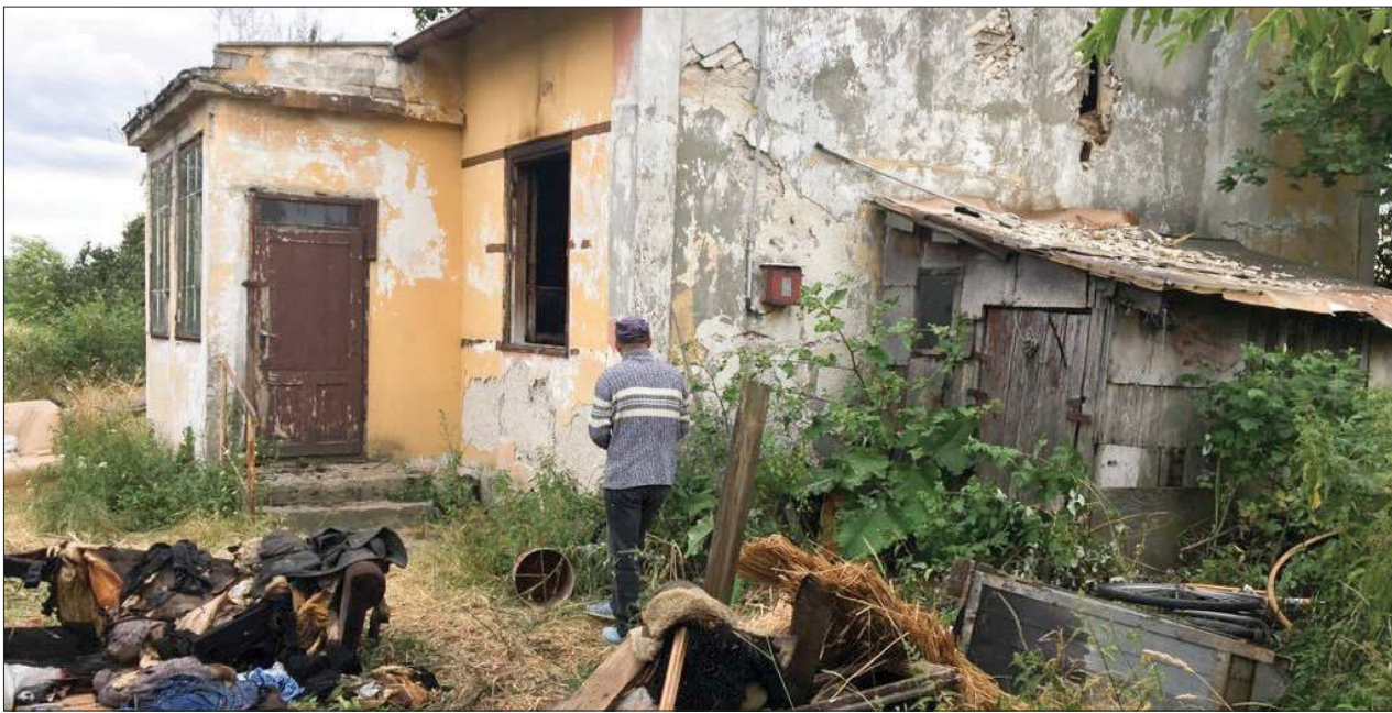
☛ Sąsiad pokazuje uszkodzoną konstrukcję domu. - Dookoła leżą ubrania, łóżko, krzesła i sprzęty. Wszystko jest spalone. Nie wiem co się wydarzyło, że doszło do tragedii. To straszne, że takie rzeczy dzieją się tuż obok nas - mówi
