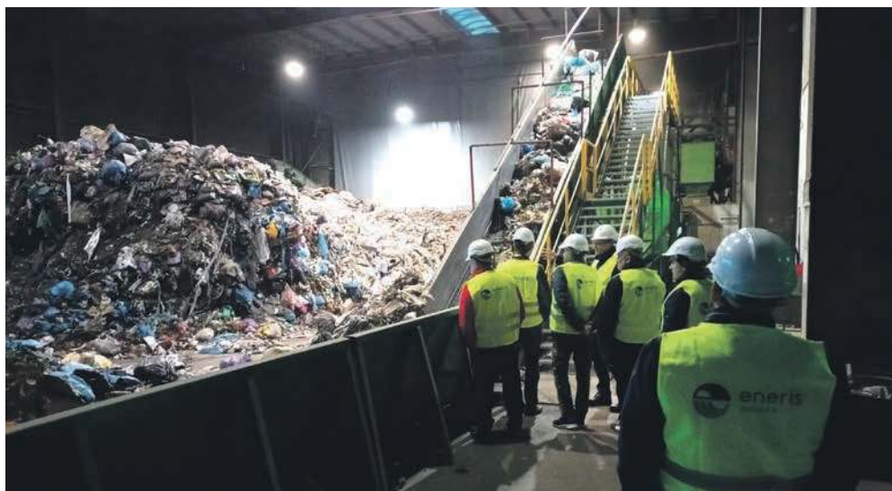
Odpady zmieszane idą taśmociągami do selekcji
