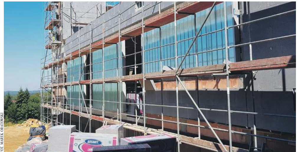
Budowa basenu rozpoczęła się dwa lata temu
