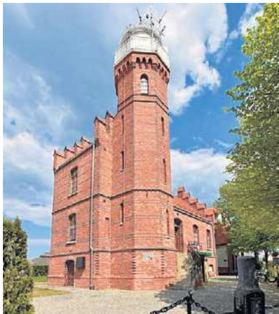
Ceglana latarnia w Ustce
