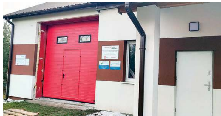
Modernizacji poddana została brama garażowa strażnicy
