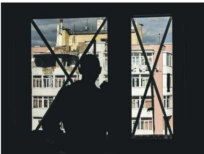
Mieszkanie w Irpieniu. Okna zaklejone taśmami. Za oknem widok sąsiedniego bloku z wyrwą po rosyjskim pocisku artyleryjskim. Irpień 24.04.2022 r.
