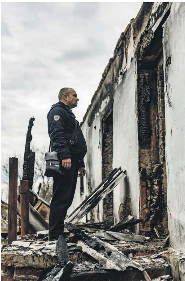
Oleg stojący przed wejściem do swojego domu, a właściwie tego, co po nim zostało. Okolice Czernichowa 27.04.2022 r.
