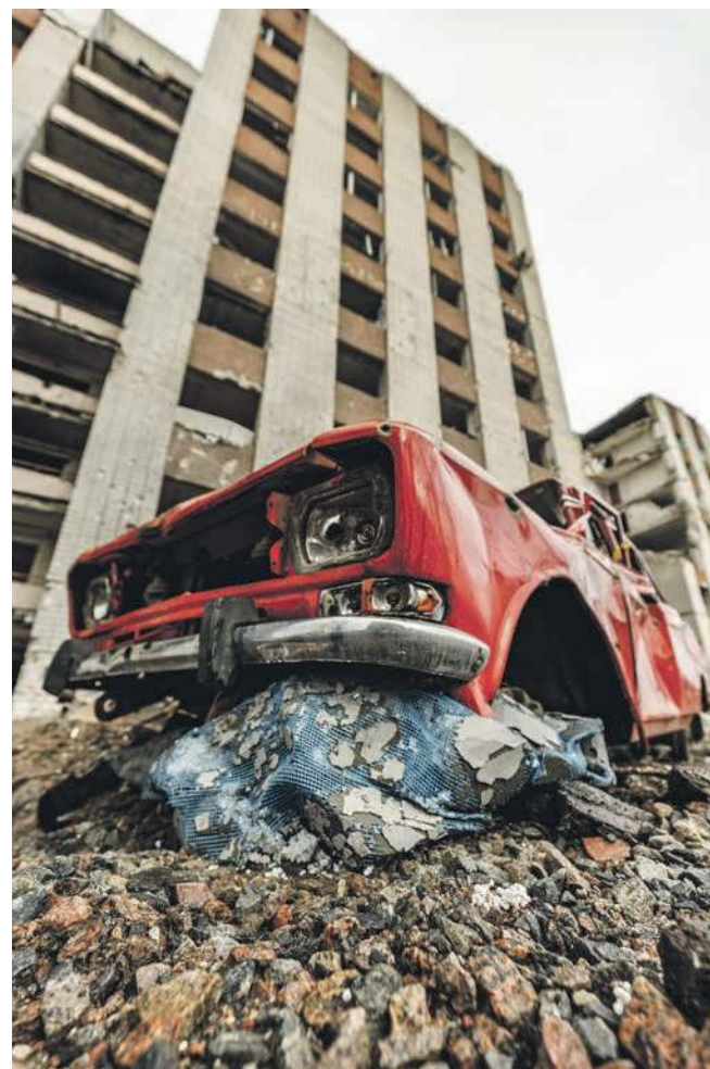
Wrak samochodu przy częściowo zburzonych blokach mieszkalnych. Efekt ostrzału artyleryjskiego Rosjan. Czernichów 26.04.2022 r.
