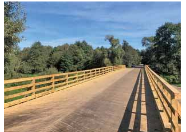
Wyremontowany most w Kępie
