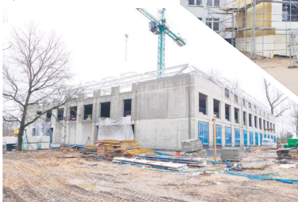
Postępują prace przy budowie ZOL w Węgrowie (zdjęcie z 26 marca 2026 r.)
