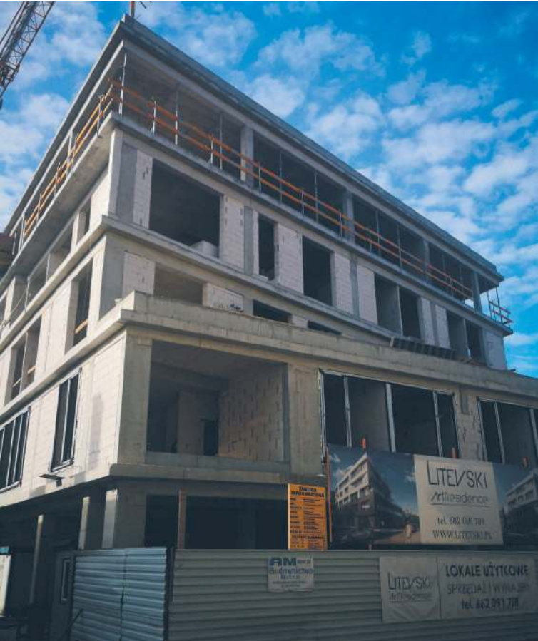
W Lublinie nowe mieszkania rosną jak grzyby po deszczu, nie tylko na obrzeżach miasta, ale także w ścisłym centrum (na zdjęciu budowa Litevski Art Residences)
