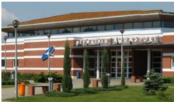
Dolnobrzezka pływalnia wymaga remontów, ale gmina na razie ma za mało pieniędzy na wyłonienie firmy w przetargu.
