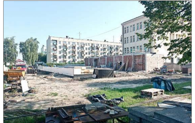
Hala sportowa powstaje obok budynku szkoły.
