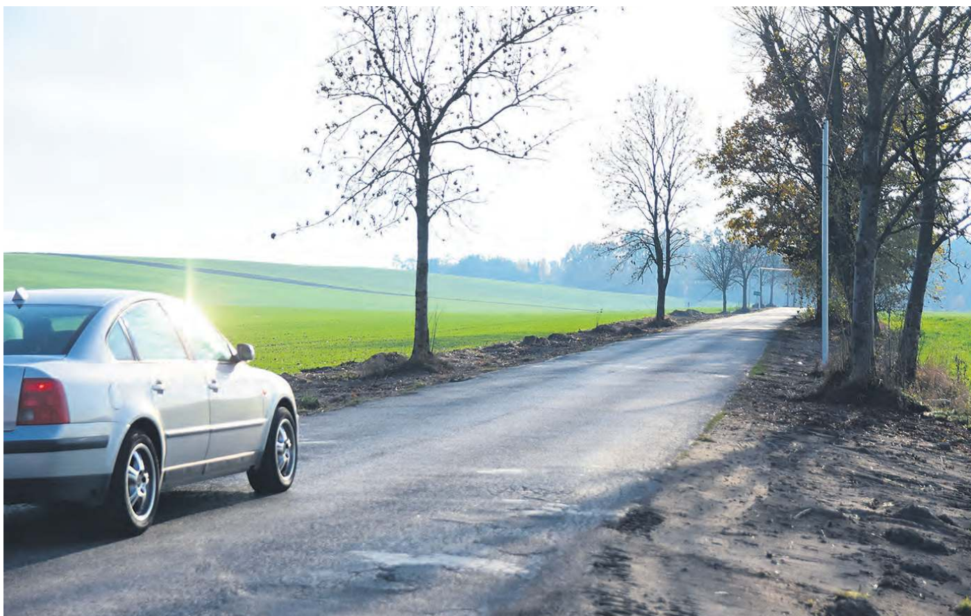
Ostrożnie! Odcinek remontowanej drogi z Kęsowa do Drożdżenicy.
