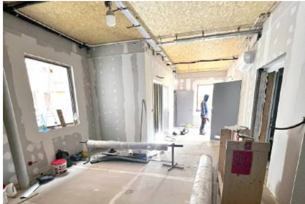
W budynkach modułowych znajdują się: sprzęt medyczny (tomograf, rezonans), ciągi komunikacyjne, pokoje badań, toalety. Inwestycja ma być gotowa w grudniu
