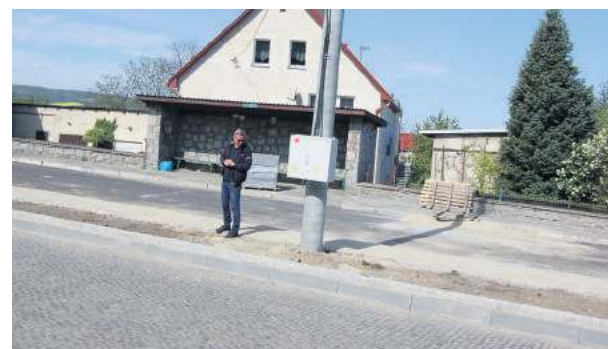
Wójt Kondratowice Tomasz Gracz dogląda remontu chodnika przy ul. Pocztowej w Prusach
