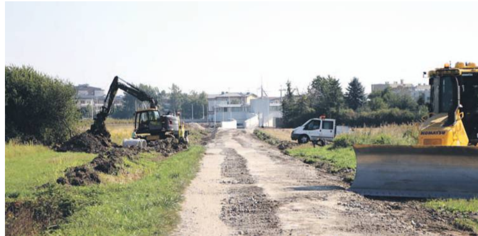
Trwają prace na odcinku od strony Nowego Otku. Droga będzie wyłożona asfaltem
