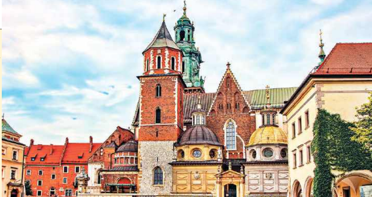
■ Bazylika Archikatedralna św. Stanisława i św. Wacława, elewacja południowa
