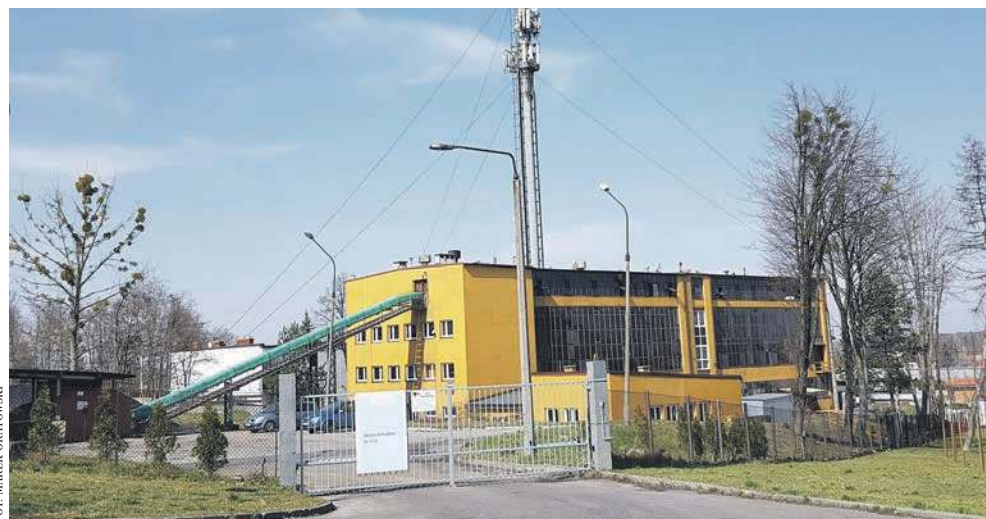
W ciepłowni węgiel mają stopniowo zastępować inne paliwa
