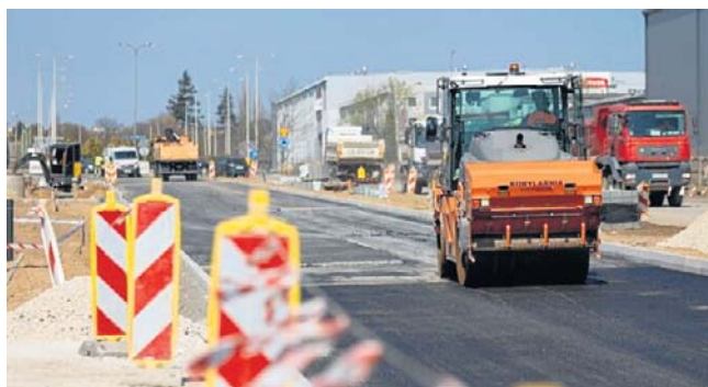
Zdjęcia z budowy ringu miejskiego
