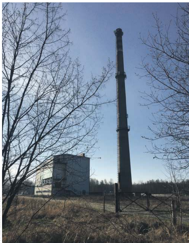
Po dawnej ciepłowni pozostał m.in. wysoki na 120 metrów komin
