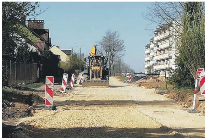
Budowa Kościelnej na osiedlu Młodości w Chrzanowie
