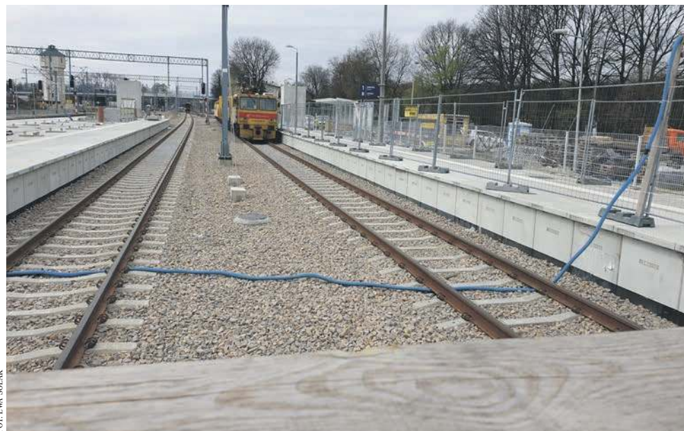
Za parę miesięcy pasażerowie będą mogli korzystać na stacji z podziemnego przejścia
