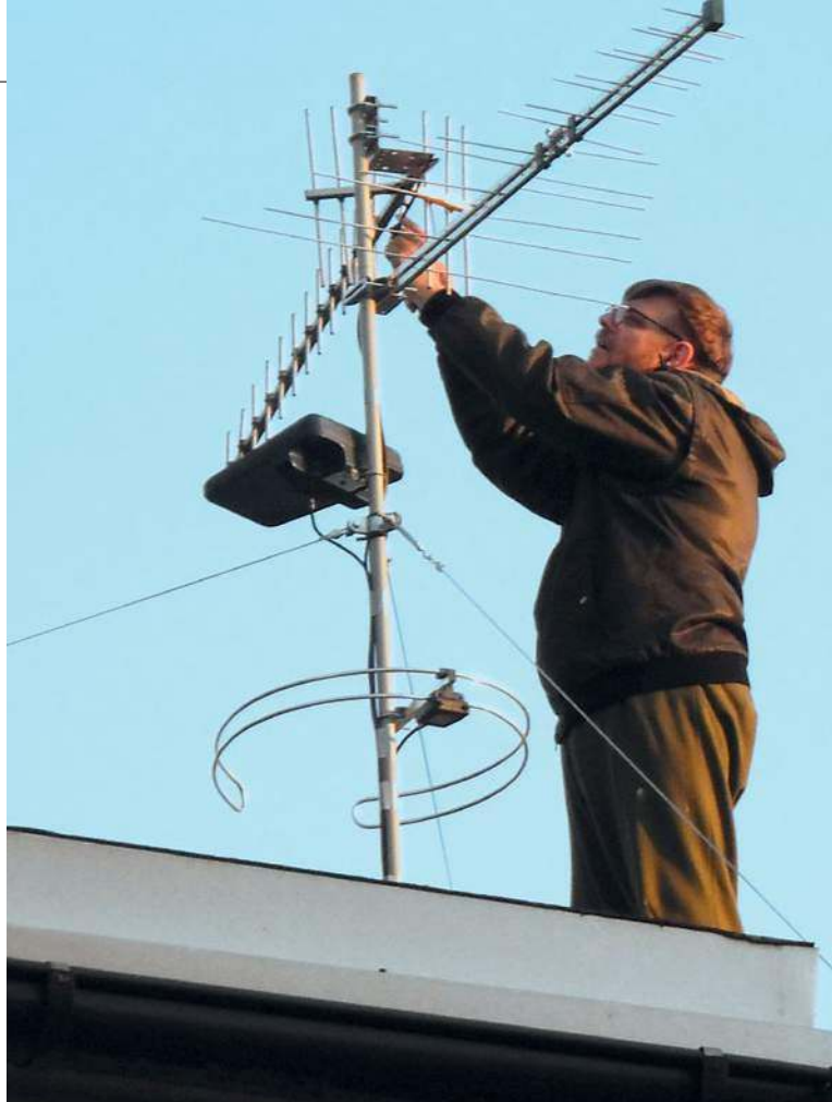
SP2LQP przy pracach antenowych (fot. M. Eichler)
