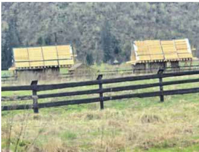
Nadzór budowlany swoje, a inwestor z USA swoje, Polana Biały Potok ginie pod kolejnymi inwestycjami.
