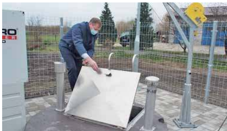
Nowa przepompownia ścieków w Rybno
