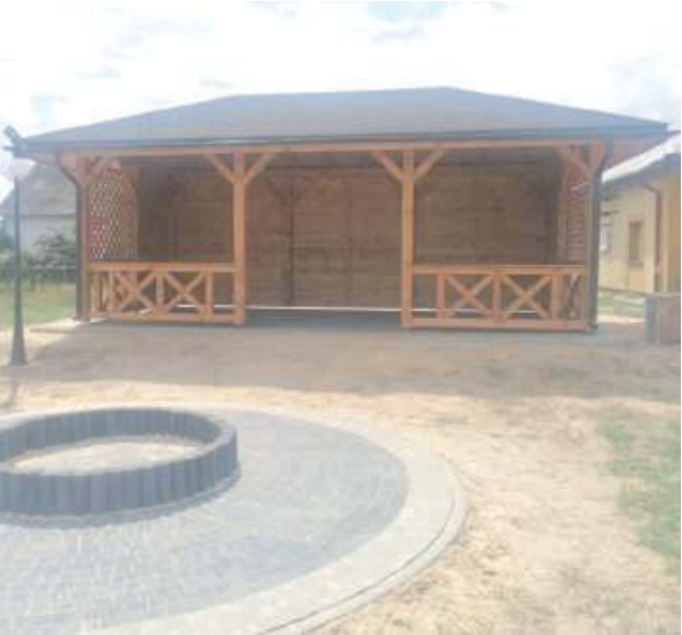
Wybudowano przestronną altanę turystyczną oraz wyznaczono miejsce na ognisko
