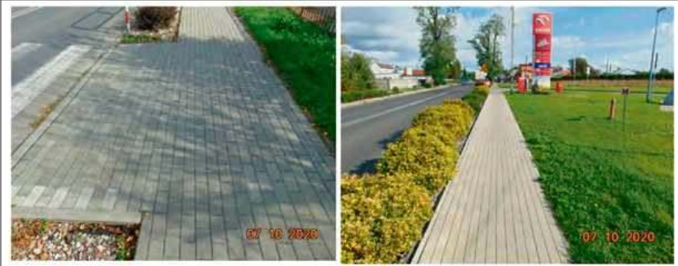
W tym roku wykonano m.in. remont chodnika na ul. Chrobrego w Zdzieszowicach przy zatoce autobusowej naprzeciw stacji paliw.
