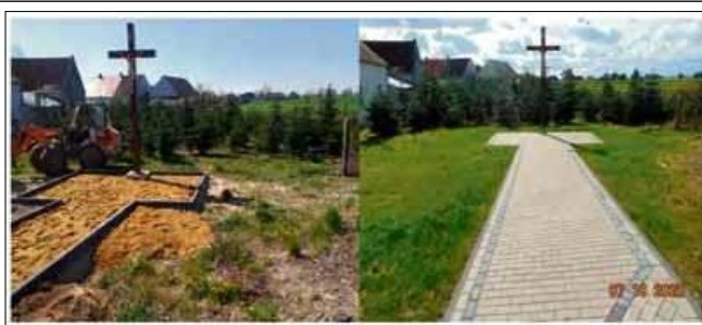
Jedną z ważniejszych inwestycji była modernizacja poboczy i chodnika w Pisarzowicach.
