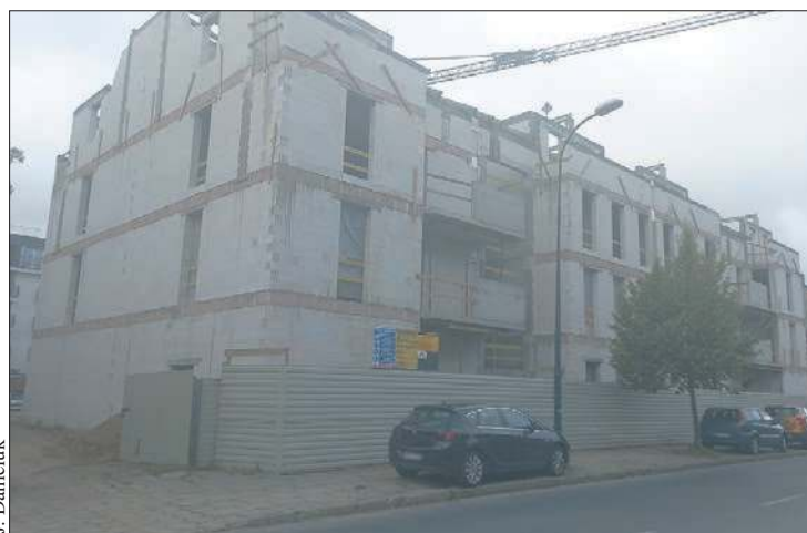
Trwa budowa bloku przy ul. Sienkiewicza 21
