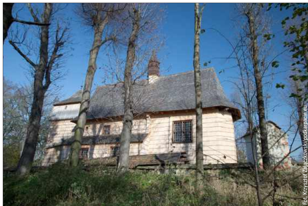
Osiek Jasielski - drewniany kościół Przemienienia Pańskiego wzniesiony około 1419 r.
