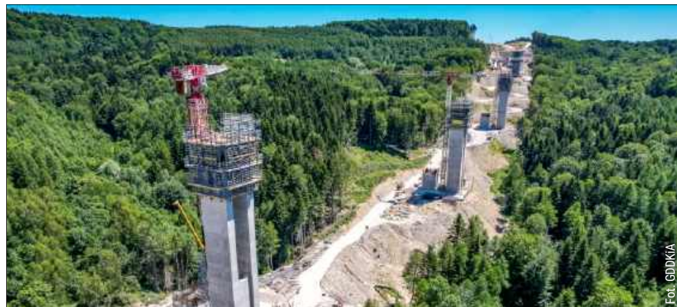
80-metrowa estakada poprowadzi w kierunku Bieszczad.
