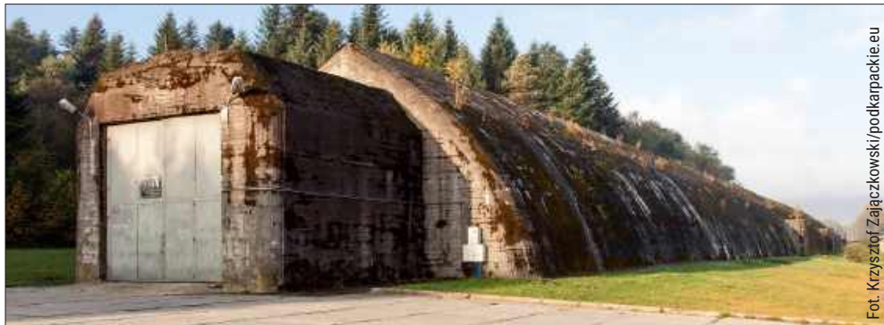
Stępina. Naziemny schron kolejowy wchodzący w skład kwatery głównej Adolfa Hitlera „Anlage Süd”.
