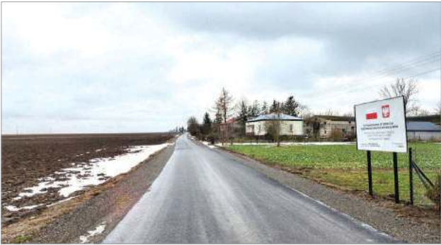
Zmodernizowana droga gminna w Teresinie
