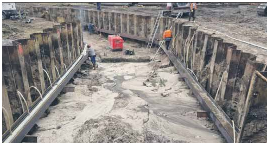
Prace przy usuwaniu awarii kanalizacji w Jeleniu. Fot: Wodociągi Jaworzno
