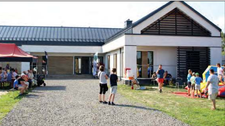
Budowa świetlicy wiejskiej w Górkach pochłonęła ponad 1 mln zł. Z tego 500 tys. zł pochodziło dofinansowania w ramach PROW
