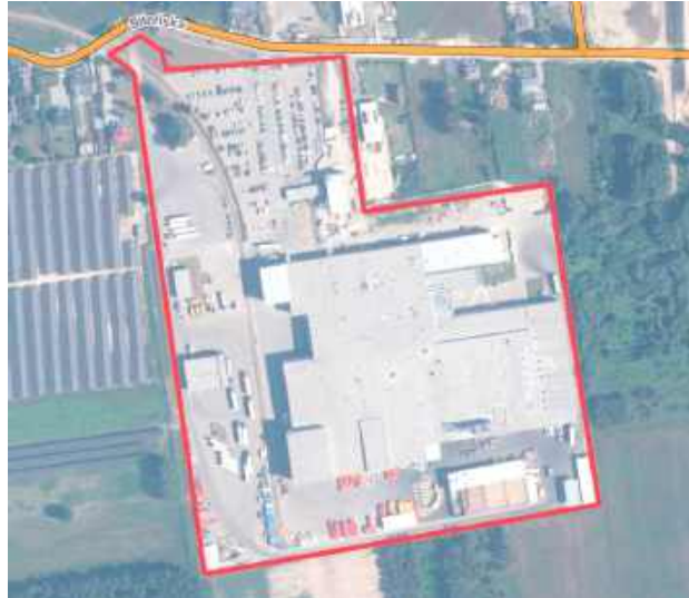
Warto zaznaczyć, że rozbudowa zakładu będzie miała miejsce w obrębie działek należących dotychczas do zakładu (nie zostaną dokupione żadne nowe działki). Obszar jest zaznaczony na czerwono
