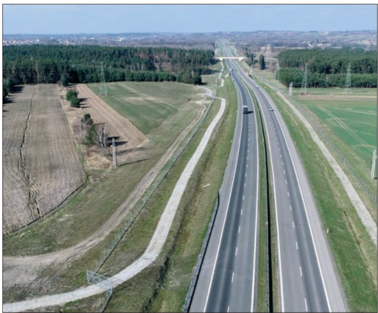
Oba obiekty staną przy dwujezdniowym, liczącym 9,6 km odcinku trasy S17, stanowiącej obwodnicę Tomaszowa Lub. Fot. GDDKiA
