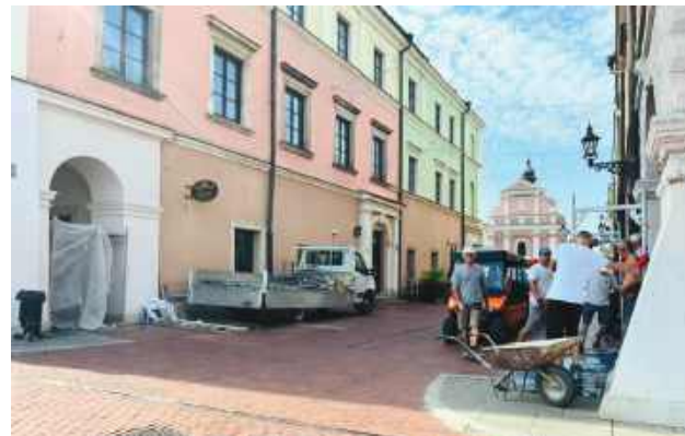
Renowacją objęte zostaną podcienia kamienic przy ul. Staszica 21 i 23, a także 25, 27, 29, 31, 33, 35, 37 i 39. Fot. UM Zamość
