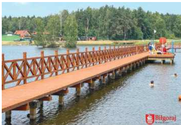
Od podpisania umowy na wykonanie robót (11 maja) do wbicia ostatniego gwoźdźca (25 czerwca 2026 roku) minęło zaledwie 45 dni.
