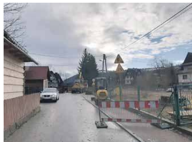
Na Królach będzie nowa nitka gazownicza, kanalizacja burzowa, w górę pociągnięty zostanie asfalt i chodnik.
