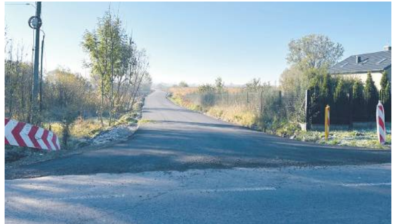
Kierowcy mogą już korzystać z nowej drogi Żółtańce - Weremowice, choć formalnie inwestycja jeszcze nie została odebrana
