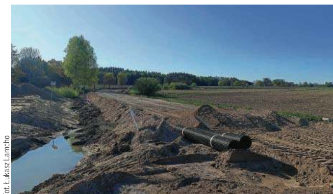
Koło Łukty na zamkniętym odcinku drogi został zerwany asfalt
