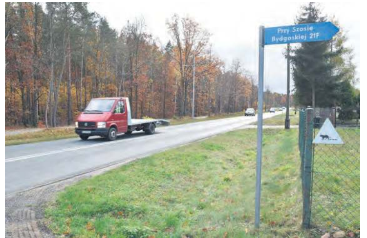
Po stronie zabudowań nie ma chodnika, dlatego też mieszkańcy wolą przejść na drugą stronę szosy, gdzie biegnie ścieżka rowerowa. Tym samym oddalają się od poruszających się aut na bezpieczniejszą odległość.
