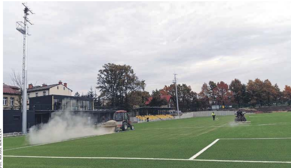
Podczas prac związanych z wypełnianiem granulem sztucznej trawy
