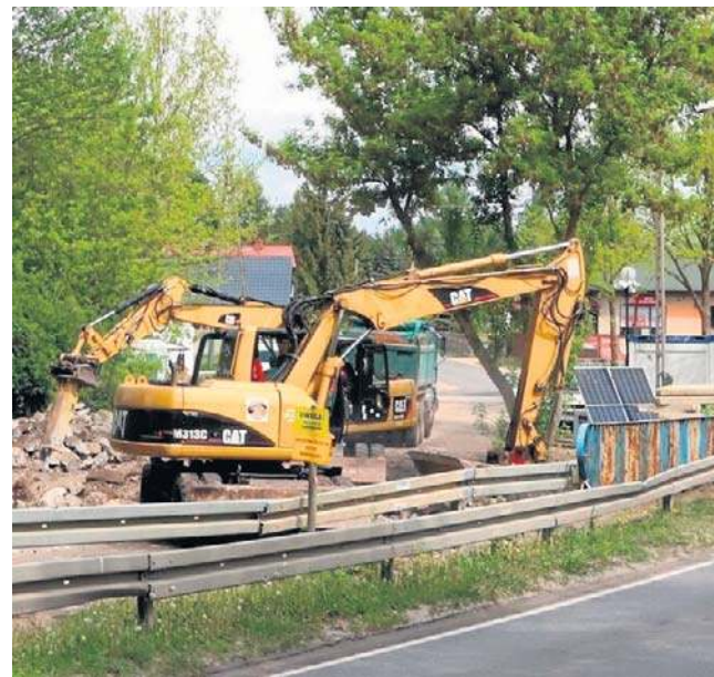
W Siczkach ruszyły roboty związane z przebudową skrzyżowania.
