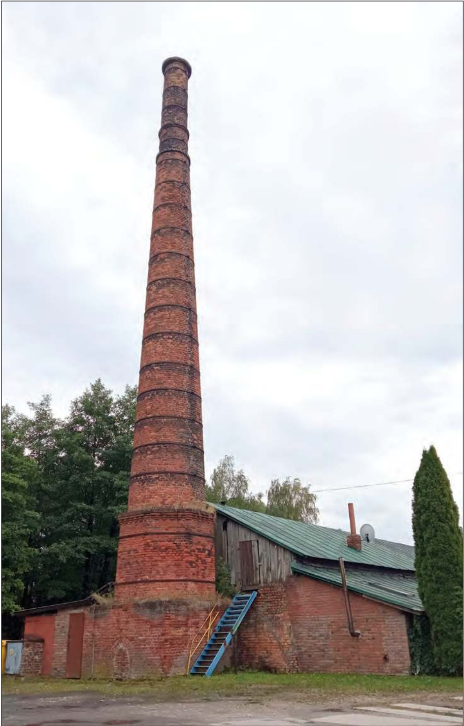
❖ Sercem cegielni był komin i pomieszczenia do wytwarzania cegły. Stosy cegieł wkładało się do tzw. rejek i zasypywało miałem węglowym. Po podpaleniu pieca od strony kominka, pracownicy dosypywali mialu aż do momentu, gdy ujrzeli, że ostatnia w stosie cegła ma czerwony od żaru kolor. Wtedy przechodziło się do następnej rejki i znów trzeba było sypać węgiel i tak dalej. A po ostudzeniu pieca należało wyjąć gotowy materiał
