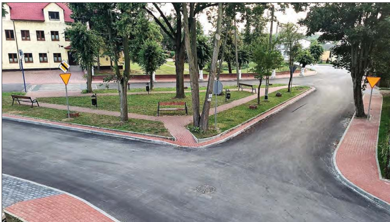
Ulica Senatorska stanowi drogę dojazdową do budynku urzędu gminy. Teraz jest równiutka i stanowi wizytówkę miejscowości
