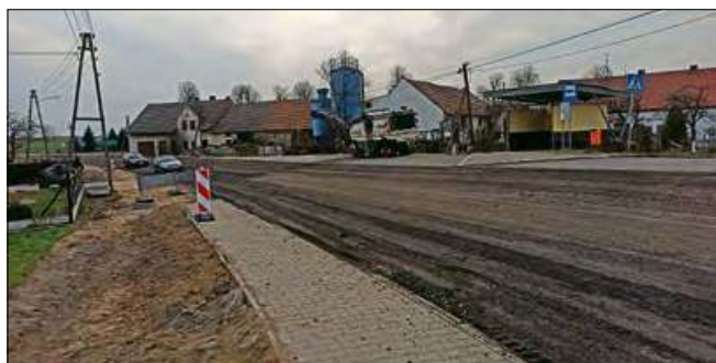
Drogowcy rozbierają dotychczasową nawierzchnię.
