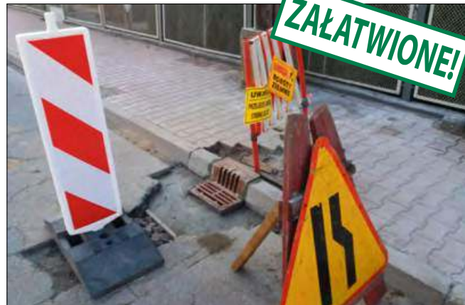
23 marca – przebudowa kanalizacji deszczowej w Górażdżach.
