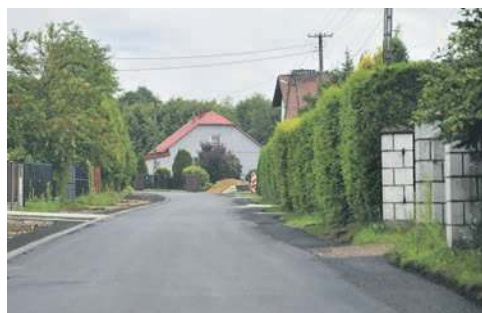
Remontowana droga z Alwerni do Brodeł
