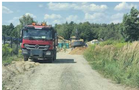
Budowa drogi w Specjalnej Strefie Ekonomicznej w Chrzanowie Kroczymiechu
