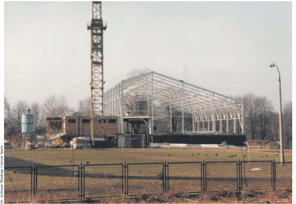
Trwa budowa krytej pływalni w Dolinie Chechła, obok SP nr 8 w Chrzanowie
