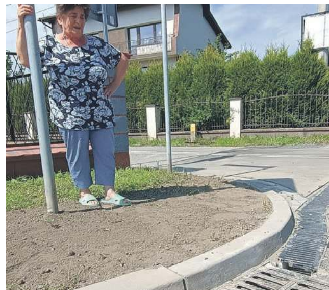
Halina Hajnos przy kratce ściekowej, która po ostatnich pracach ma już odbierać wodę po opadach deszczu
