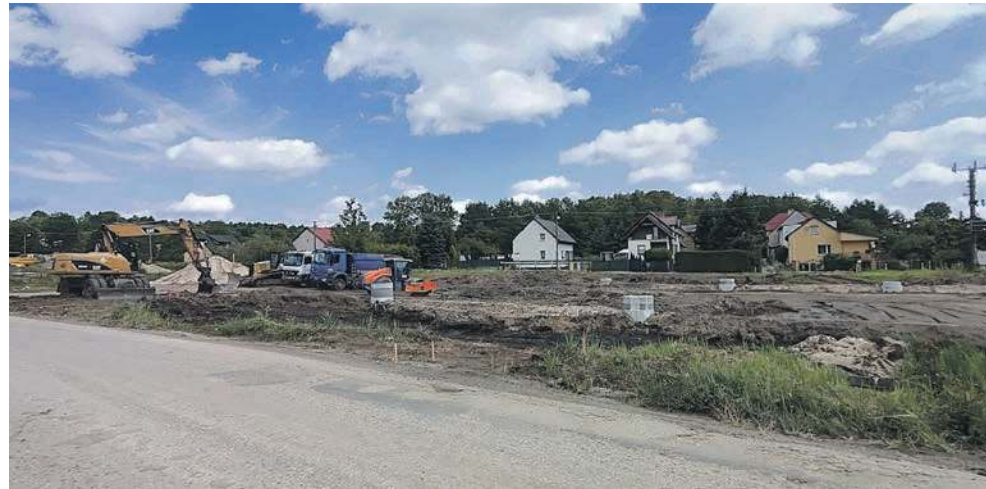
Na Sikorskiego w Trzebini powstanie rondo
